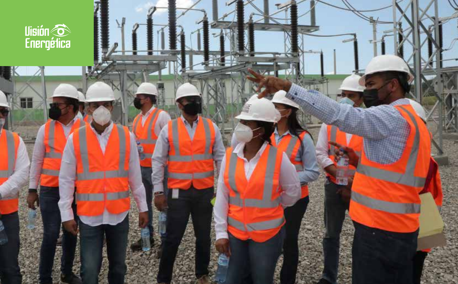
Equipo de técnicos de la Dirección Eléctrica de la CNE en la subestación del Parque Solar Girasol.
