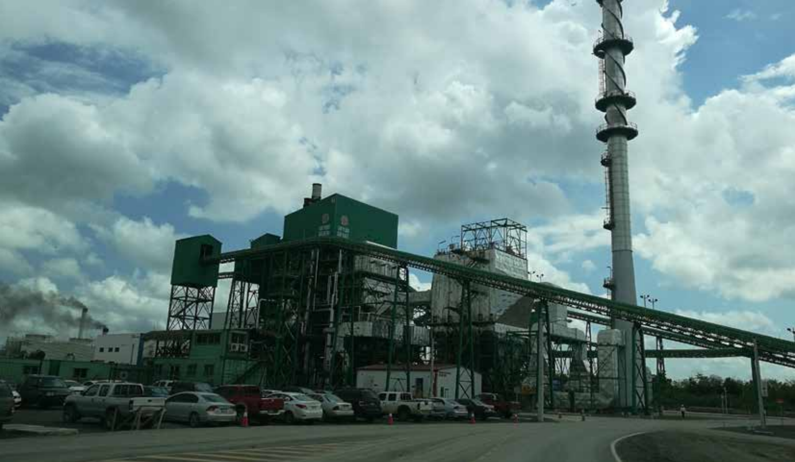
Planta de biomasa de San Pedro Bio Energy en San Pedro de Macorís, que usa bagazo de caña procedente del Ingenio Cristóbal Colón.
