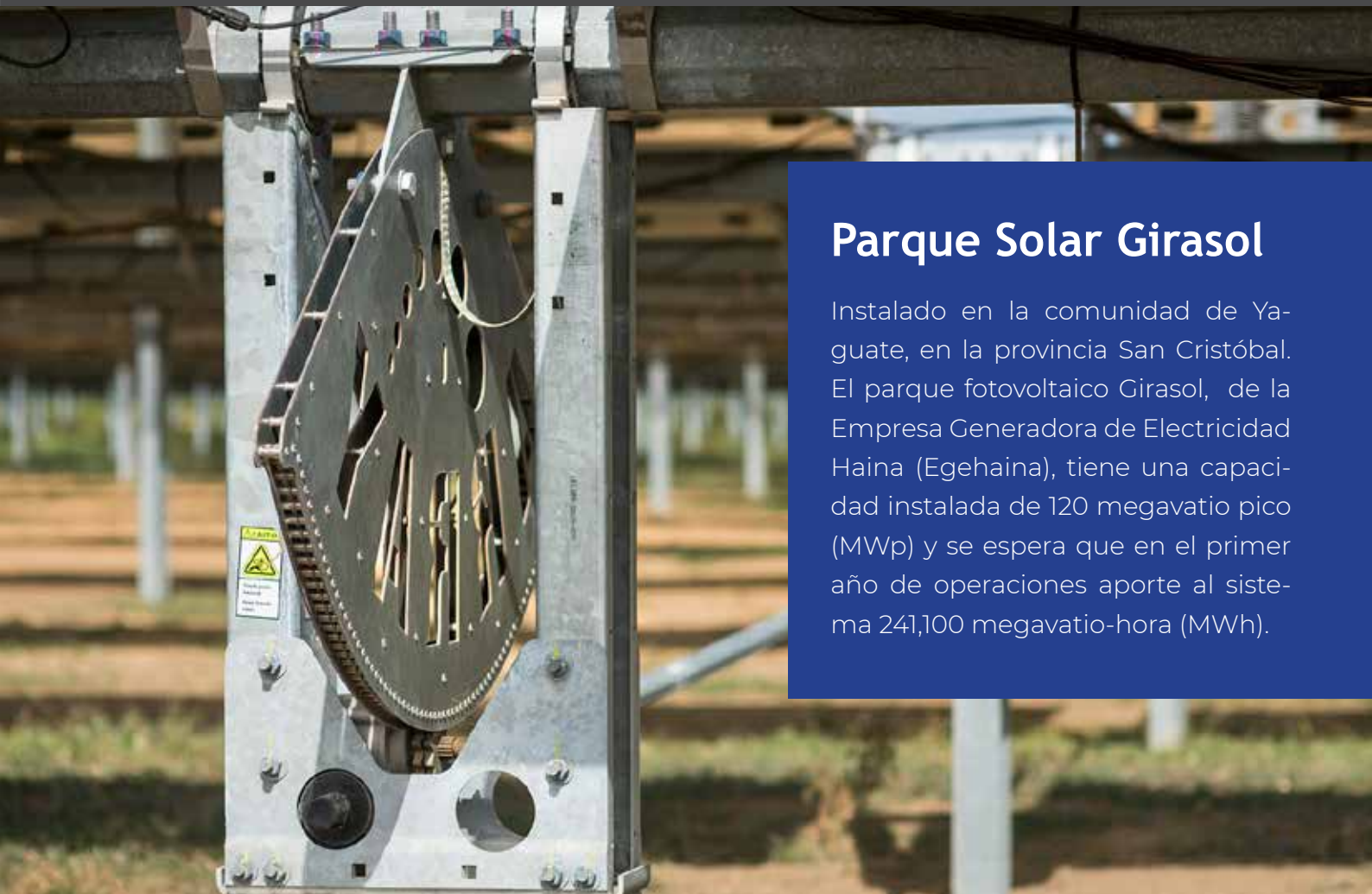
Sistema de seguimiento (traker) instalado en el parque solar Girasol.
