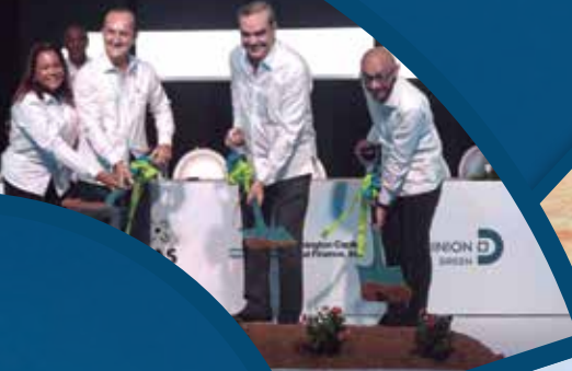
Parque fotovoltaico Washington Capital Solar Park 2 y 3
